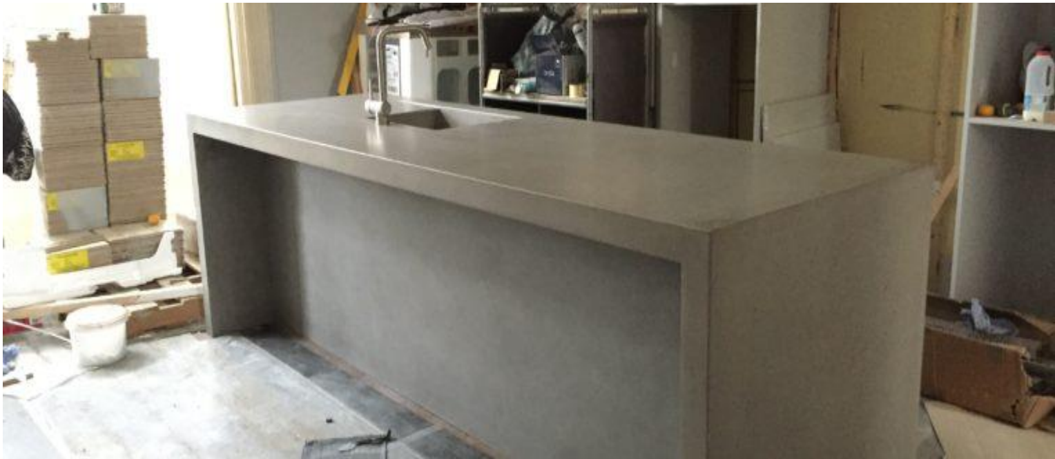
Mosogató pult (design beton)
